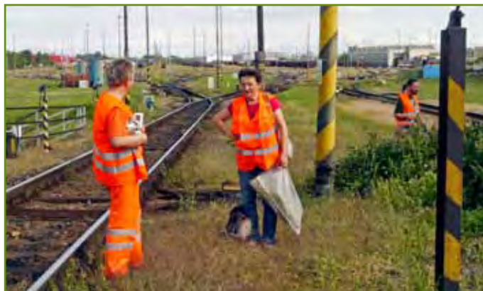
Pracovníci BoÚ SAV pri práci v ŽST Bratislava východ.
